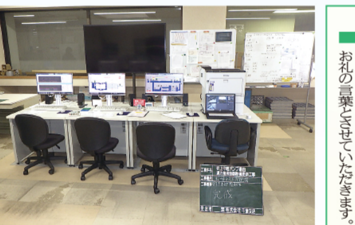
昱千葉支店 吹上中継ポンプ場他遠方監視制御設備更新工事
